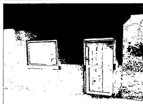
Foto 6: Sustitución de puerta de madera por metal y de ventana por balcon.
